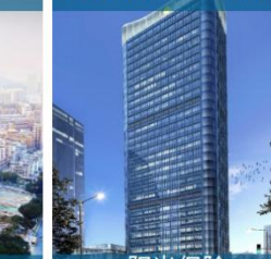
阳光保险 深圳总部大厦
