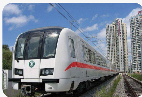
詹天佑奖项目:深圳地铁3号线项目
