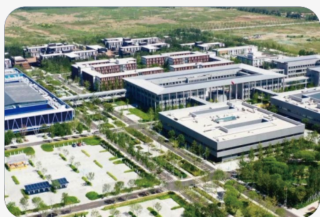
鲁班奖项目:雄安市民中心项目
